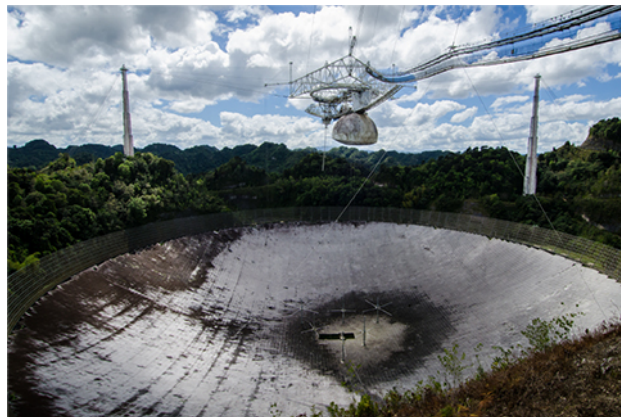
ILUSTRACJA 4.20 Radioteleskop o średnicy 305 m w obserwatorium Arecibo w Portoryko. Jest on wyłożony materiałem odbijającym i stanowi największą skupiającą zakrzywioną powierzchnię na świecie. Chociaż jego średnica D jest większa niż teleskopu Hubble'a, wykrywa on fale promieniowania o znacznie większej długości i jego dyfrakcyjna granica rozdzielczości zdecydowanie pogarsza się w porównaniu z przypadkiem teleskopu Hubble'a. Teleskop w Arecibo jest nadal bardzo przydatny, ponieważ niektóre ważne informacje o obiektach kosmicznych przekazywane falami radiowymi nie są przesyłane z wykorzystaniem światła widzialnego. Źródło: Jeff Hitchcock
