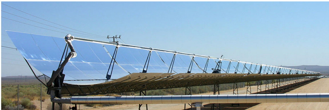
ILUSTRACJA 2.11 Paraboliczne zwierciadła wykorzystywane do generowania energii elektrycznej w południowej Kalifornii. Źródło: „kjkolb”/Wikimedia Commons
